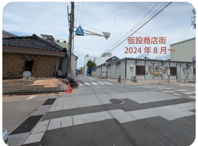
地震の前から道路舗装の修復は頻繁に必要でした
